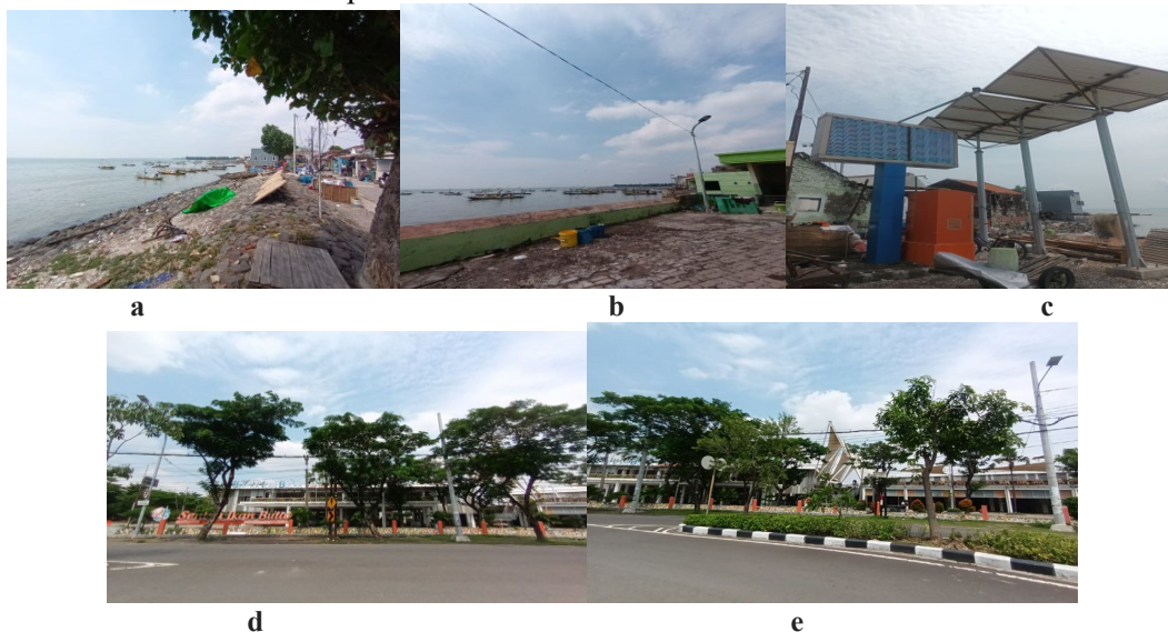
Gambar 2 Kondisi lokasi studi di area terdampak bencana banjir rob. a: Tanggul dari batu untuk penahan air laut; b: Pagar pembatas beton penahan air laut c; Alat pencatat cuaca dan kecepatan angin yang dipasang di bibir pantai Kenjeran, Kecamatan Bulak d; dan e; Sentra Ikan Bulak yang kini kosong dari penjual (Source: Author's documentation, 2023)
