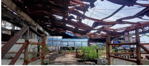
Gambar 1. 4 Kondisi Eksisting Lantai 2 (Sumber : Penulis, 2023)
