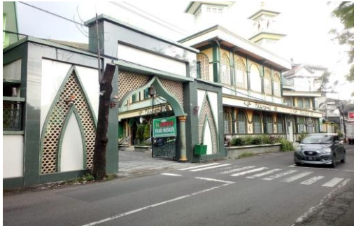
Gambar 4. Fasilitas bagi pejalan kaki yang masih kurang.
