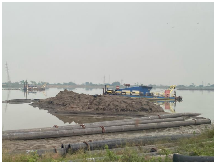
Gambar 1.3 Alat berat untuk penggalian lumpur yang mengendap
