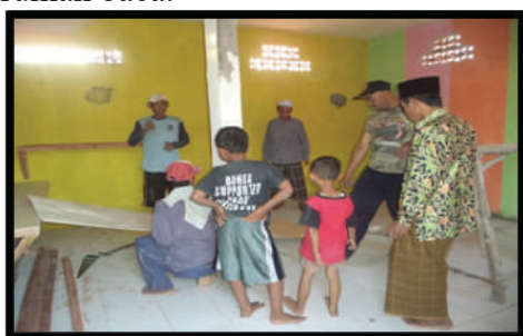
Gambar 3. Pembangunan rumah baca.
