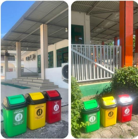
Gambar 4. Instalasi Tong Sampah Pilah untuk Waste Management
