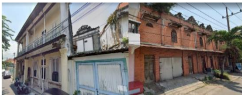
Gambar 3. Bangunan lama (Sumber: Dokumentasi Tim, 2022)
