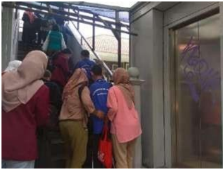
Gambar 4. Elevator jembatan penyeberangan yang tidak berfungsi, menyebabkan rombongan harus menaiki tangga yang cukup tinggi untuk menyeberang Jalan Raya Darmo.
