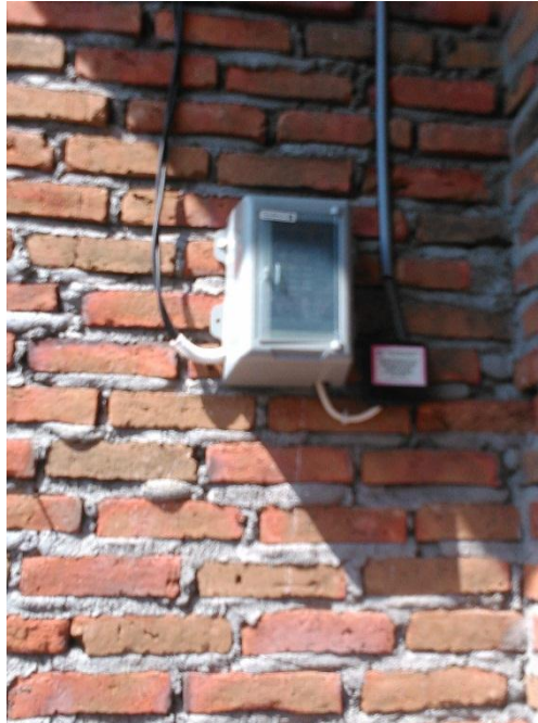
Gambar : 3.36, Pemasangan KWh meter yang baik
