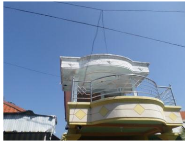
Gambar 3.17, Pemasangan Kabel melintang di jalan.
