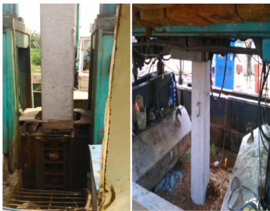
Gambar 4 Pencepatan tiang pancang Sumber: Arif Rahman Hakim, 2018
