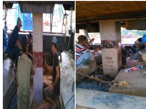
Gambar 4 Pengelasan tiang pancang Sumber: Arif Rahman Hakim, 2018
