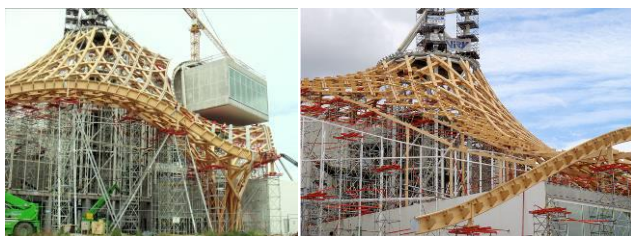
Gambar 14. Proses Konstruksi Pompidou Centre Metz Sumber : Mossot 2010, wikipedia
