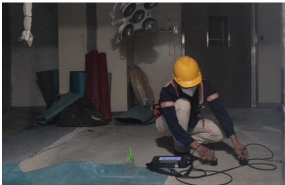
Gambar 1. Dokumentasi pengujian Ultrasonic Pulse Velocity Test Sumber : Dokumentasi Survey
