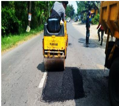
Gambar 11 Proses Pemadatan menggunakan Tandem Roller 2 ton Sumber : UPT Pengelolaan Jalan dan Jembatan Kabupaten Mojokerto
