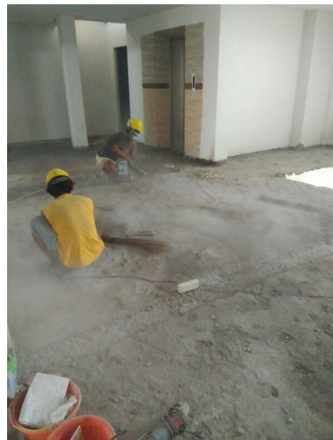
Gambar 1: pengupasan lantai keramik.dan perataan lantai beton
