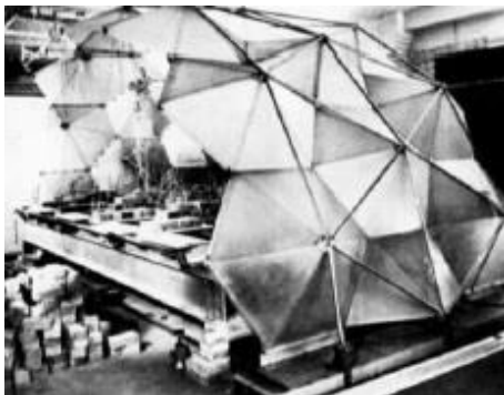
Gambar 3., Kerangka grid spasial dengan lembaran tipis bidang Sumber: Genzel & Voigt, 2005)
